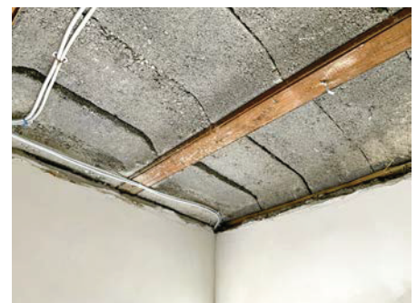
(4) Massivdecken mit Eihängesteinen weisen viele Hohlräume auf und haben meistens eine direkte Verbindung nach außen. Falls nur das Dachgeschoss ausgebaut wird, muss auch die Luftdichtheit der darunterliegenden Decke betrachtet werden.
