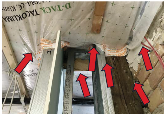
(3) Das könnte man mit etwas Nachdenken besser machen. Alle diese Fehler (im Bild markiert durch rote Pfeile) sind vermeidbar und ungeeignet für die Ausrede, dass 100 % Luftdichtheit im Altbau nicht machbar seien.
