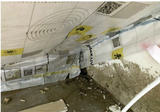
(2) Der Folienanschluss sollte an Ringanker oder verputztes Mauerwerk erfolgen, nicht wie hier an die Fußpfette. Auch der häufig gesehene Anschluss an den Estrich ist falsch, da hier eine Hinterströmung wahrscheinlich ist.
