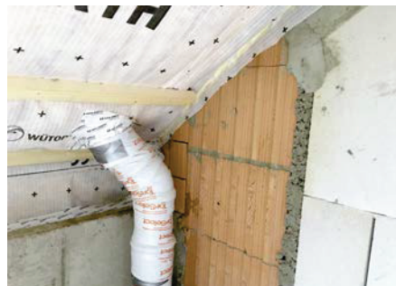
(10) Später nicht mehr sichtbare Bereiche sollten mit einem Glattnstrich versehen werden, wie in DIN 4108-7 ausgeführt.
